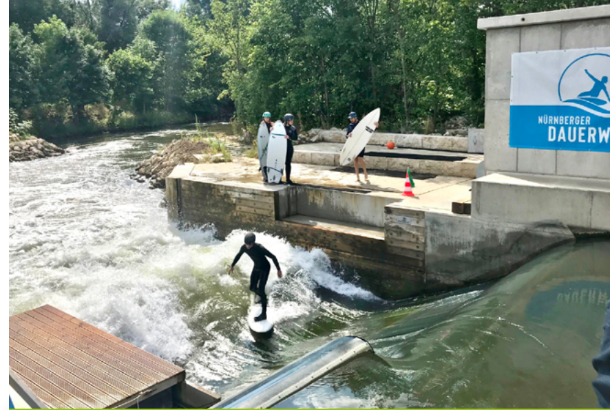
Dem Verein Nürnberger Dauerwelle e. V. ist es gelungen, ein wasserbaulich in Deutschland einzigartiges Projekt zu realisieren: Die erste hydraulisch verstellbare Surfwellen, welche sowohl eine wassersportliche Nutzung ermöglicht, aber auch den Belangen des Naturschutzes gerecht wird (die Fischaufstiegsanlage ist nicht mit abgebildet). © DWA-LV Bayern
