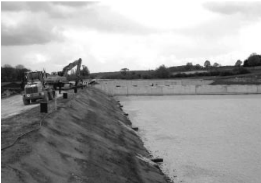
Bau des Retentionsbodenfilters
