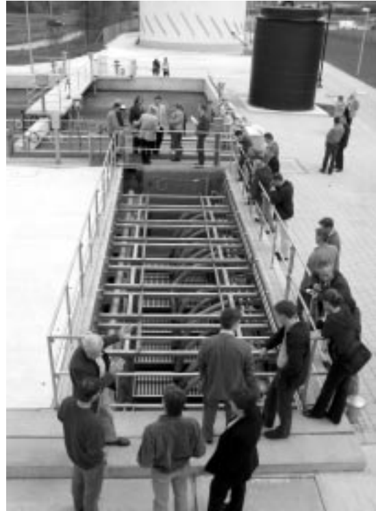
Die Membranbelebungsanlage der Kläranlage Monheim
