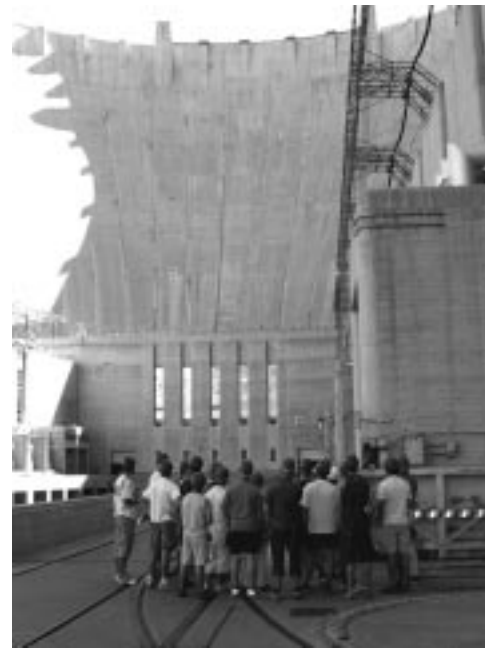
Besuchsgruppe der UniBwM am Fuß der Schwerkraftsbogenmauer des Hoover Dam
