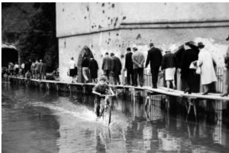
Die Uferstraßen waren alle überflutet, wie hier Ottos Kellerstuben an der Donau und nur auf Stegen passierbar, die auch heute bei Hochwasser noch zum Alltag in Passau gehören.
