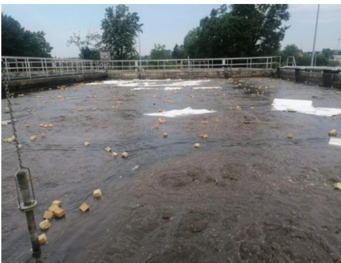
Abb. 8: Öl-Ex-Würfel werden in der Belebung eingesetzt
