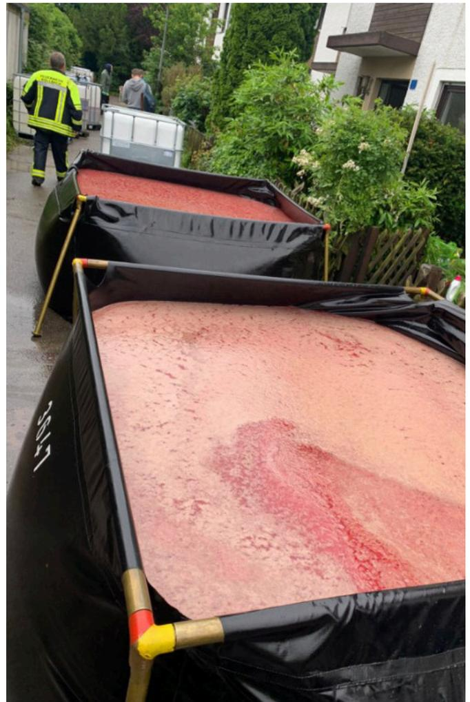
Abb. 9: Die Feuerwehr pumpt in mobile Auffangbehälter
