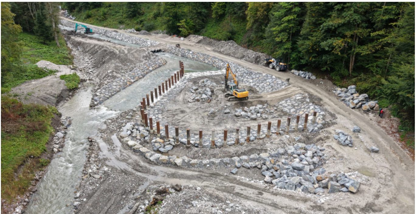
Abb. 10: Nach Fertigstellung der Bohrpfählarbeiten folgten Steinarbeiten zur Gerinne Anpassung und Pflasterarbeiten zur Sicherung des Retentionsraumes (© Markt Garmisch-Partenkirchen)
