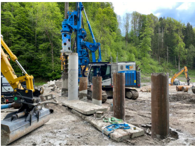
Abb. 8 / 9: Gründung der Bohrpfähle (links) Steinarbeiten am Gerinne (rechts) (© WWA Weilheim)
