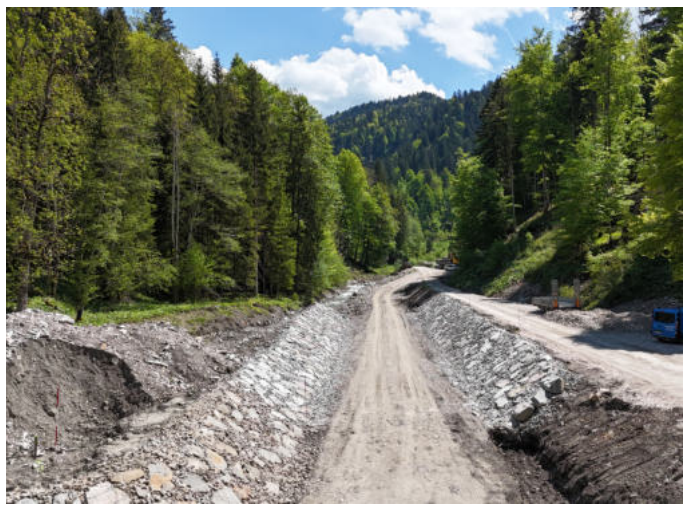
Abb. 6/7: Wiederherstellung des Forstweges als Zufahrtsstraße der Baustelle. An besonders rutschgefährdeten Bereichen musste die Sicherung der Straße mit bewehrter Erde erfolgen. © WWA Weilheim
