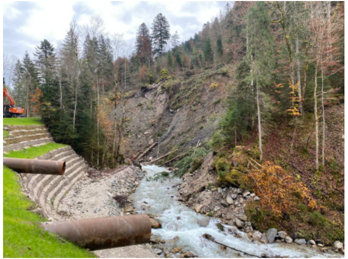
Abb. 6/7: Wiederherstellung des Forstweges als Zufahrtsstraße der Baustelle. An besonders rutschgefährdeten Bereichen musste die Sicherung der Straße mit bewehrter Erde erfolgen. © WWA Weilheim
