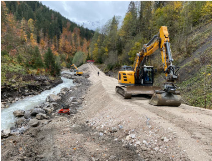
Abb. 6/7: Wiederherstellung des Forstweges als Zufahrtsstraße der Baustelle. An besonders rutschgefährdeten Bereichen musste die Sicherung der Straße mit bewehrter Erde erfolgen. © WWA Weilheim
