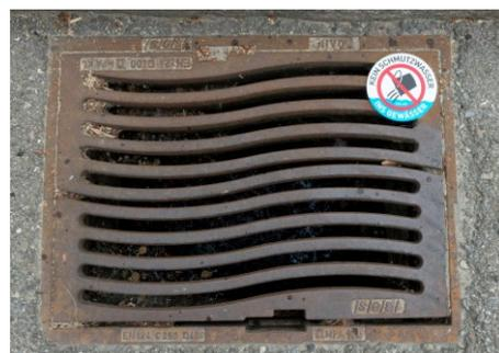
Hier ist zu beachten, dass die Einlauffläche bzw. der Querschnitt reduziert wird!
